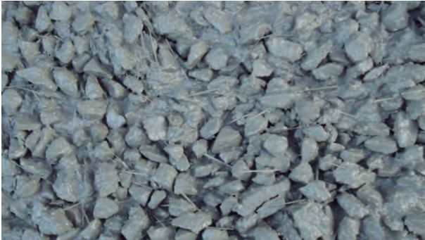
Correcta distribución de las Fibras en todo el pavimento.
