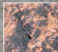
Fibras en hormigón fresco
