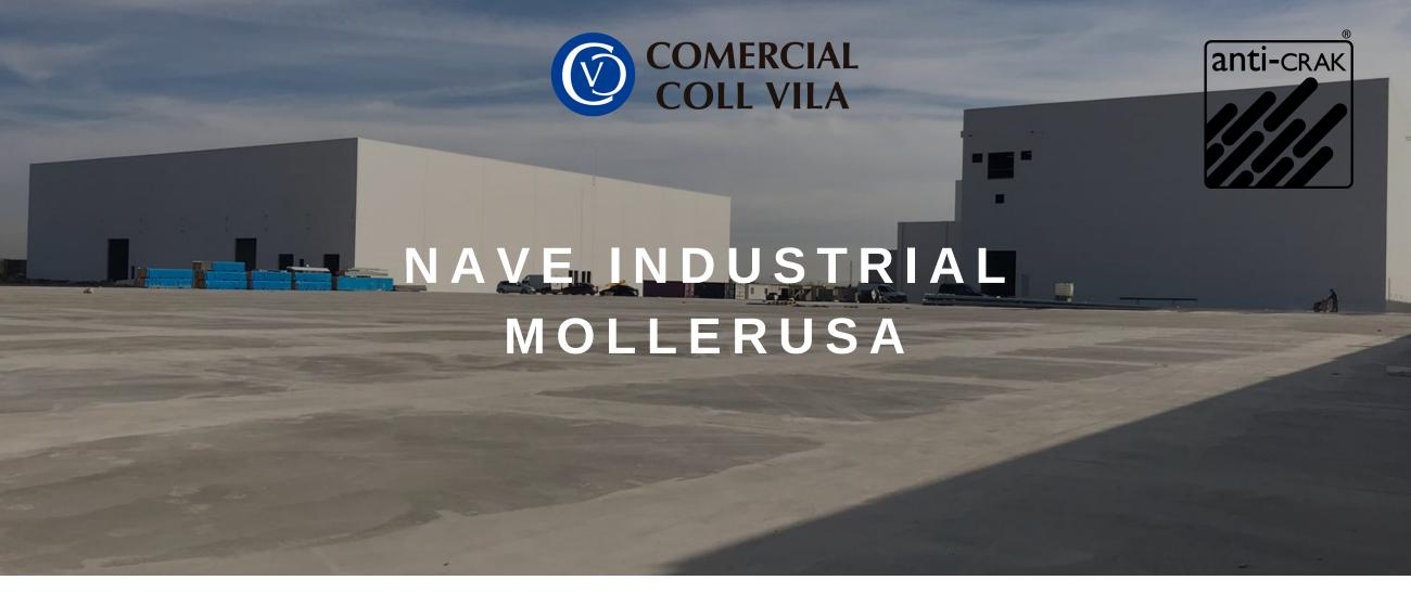
Referencia **Ubicación** Ingeniería **Espesor Formulación** Ingersa Anti-Crak 15 cm Hormigón Mollerusa, HP 67/36 Lérida HAF-25 **Fecha Planta Acabado** Dosificación **Juntas** 4 kg / m3 Garrofé 5 x 5 Fratasado 2020
