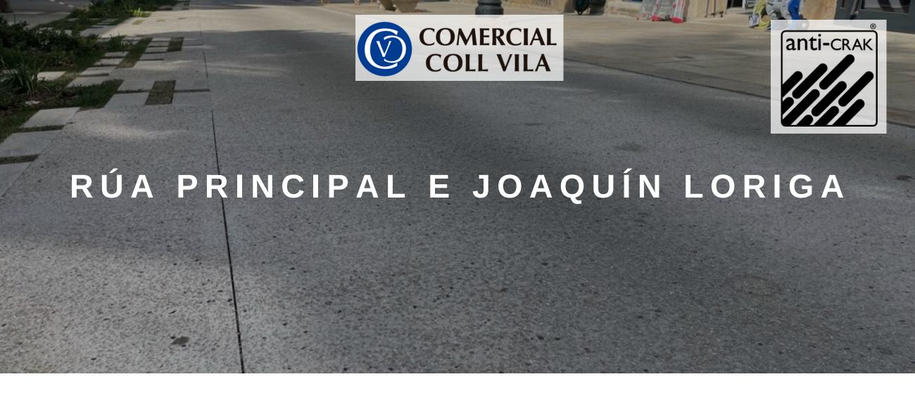
Referencia **Ubicación Espesor Formulación Constructora** 15 cm Anti-Crak Lalín Oresa Hormigón Pontevedra HP 67/36 HA-25 **Dosificación Fecha Planta Acabado** Juntas Marbe 4 x4 Desactivado 3 kg / m3 2021 Hispania
